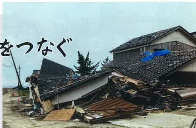
令和6年能登半島地震での被災地の様子（社協被災地支援ボランティア活動の記録写真より引用）
